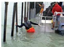
Le travail avec des barges peut nécessiter un guidage manuel des embarcations entre les pieux. En fonction de l'état de la mer et des conditions climatiques ce travail de guidage peut s'avérer dangereux et l'opérateur peut se trouver coincé entre la barge et des pieux.
